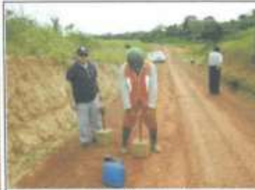
Foto 02: Compactación de Badhes (bacheo), en un Mantenimiento Rutinario.
