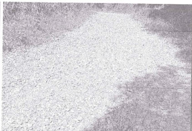
foto 214: Erosión, de nivel de gravedad 2, en la progresiva 7+520 al 7+615
