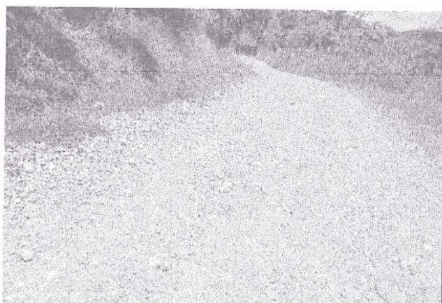
foto 201: Erosión, de nivel de gravedad 2, en la progresiva 6+280 al 6+358
