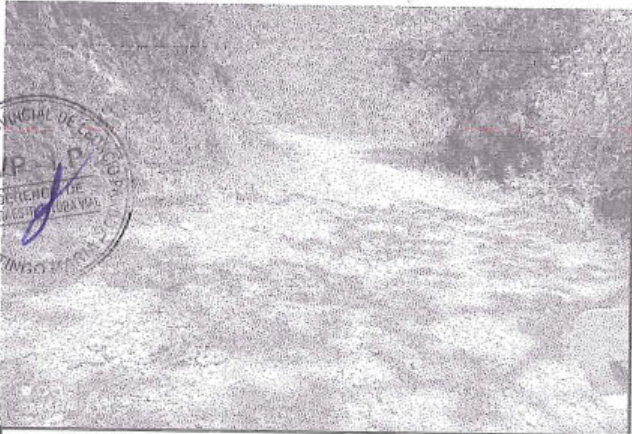
foto 193: Erosión, de nivel de gravedad 2, en la progresiva 5+470 al 5+500
