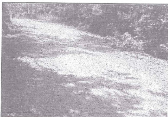
foto 13: Superficie de rodadura con afirmado, en la Progresiva 1+500, con estado de transitabilidad regular.
