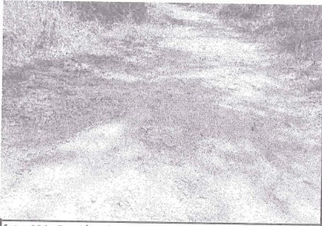
foto 191: Erosión, de nivel de gravedad 2, en la progresiva 5+200 al 5+355
