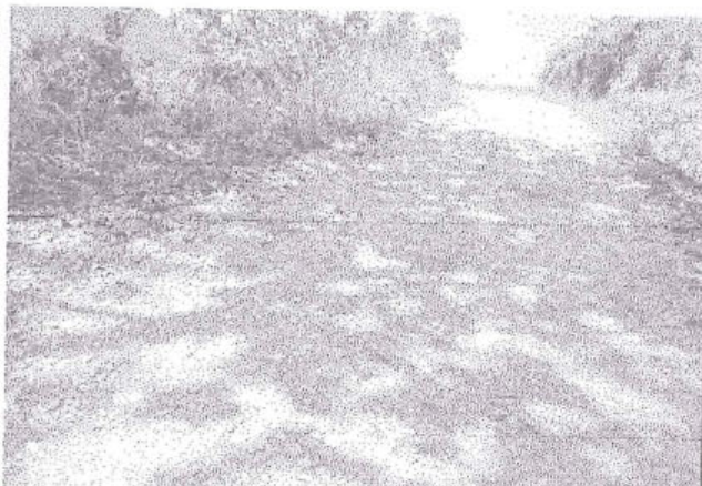
foto 216: Deformacion, de nivel de gravedad 1, en la progresiva 7+750 al 7+845
