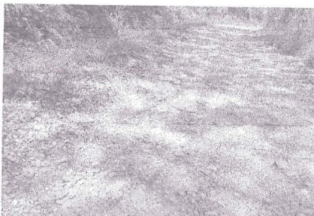
foto 200: Erosión, de nivel de gravedad 2, en la progresiva 6+130 al 6+251
