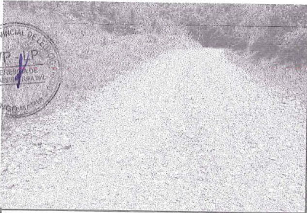
foto 229: Deformacion, de nivel de gravedad 2, en la progresiva 9+020 al 9+122
