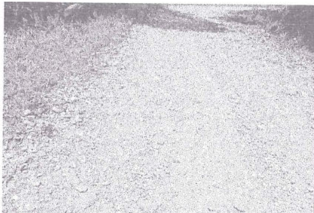
foto 222: Erosión, de nivel de gravedad 1, en la progresiva 8+350 al 8+451
