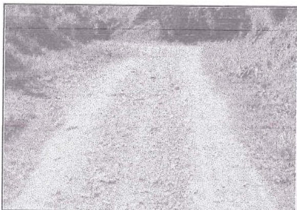
foto 57: Superficie de rodadura afirmado, en la Progresiva 6+000, con estado de transitabilidad bueno.
