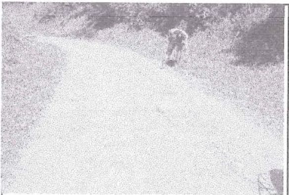
foto 71: Superficie de rodadura afirmado, en la progresiva 7+500, con estado de transitabilidad regular.
