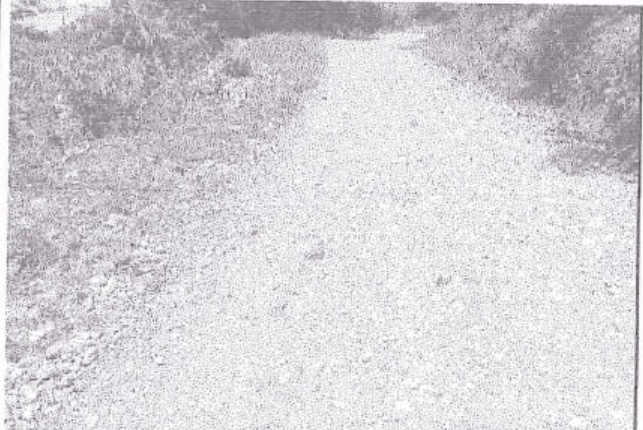
foto 192: Erosión, de nivel de gravedad 1, en la progresiva 5+360 al 5+459
