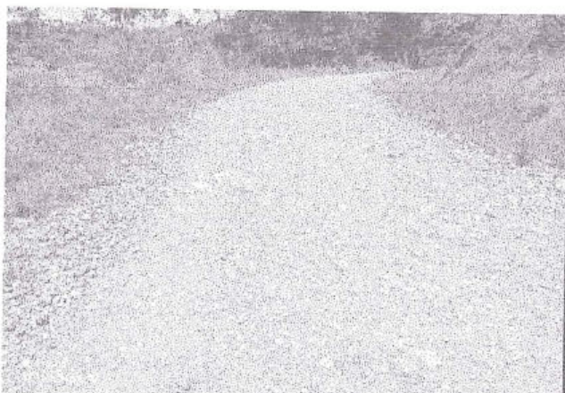
foto 219: Deformacion, de nivel de gravedad 1, en la progresiva 8+020 al 8+131
