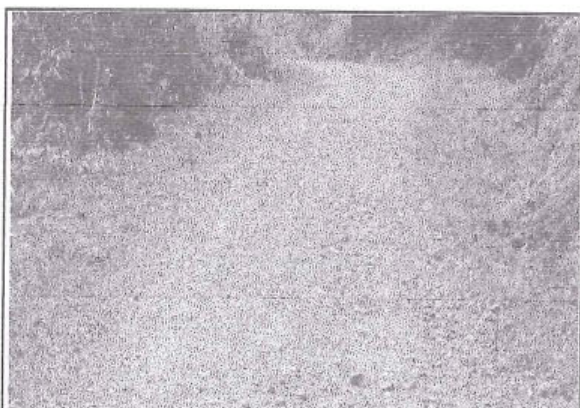
foto 65: Superficie de rodadura afirmado, en la progresiva 7+000, con estado de transitabilidad regular.
