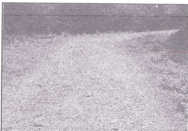
foto 138: Superficie de rodadura afirmado, en la progresiva 0+500, con estado de transitabilidad regular.
