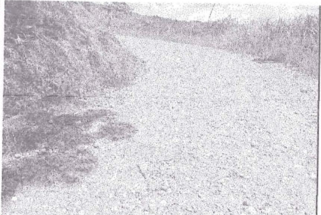
foto 204: Erosión, de nivel de gravedad 2, en la progresiva 6+500 al 6+614
