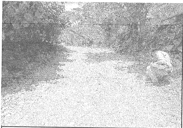
foto 172: Deformacion, de nivel de gravedad 2, en la progresiva 3+180 al 3+224
