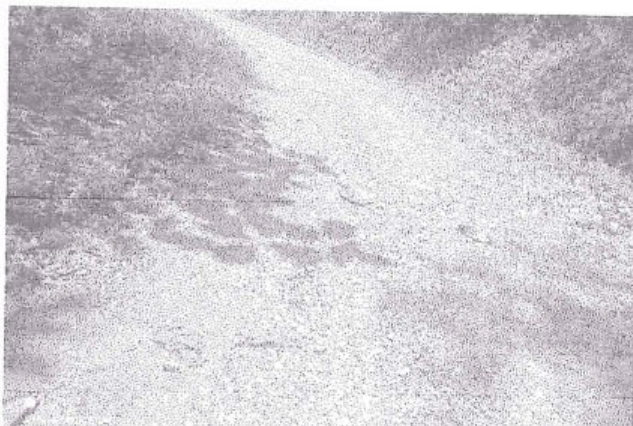
foto 246: Erosión, de nivel de gravedad 2, en la progresiva 10+625 al 10+722
