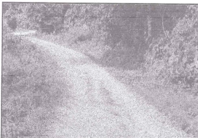
foto 140: Superficie de rodadura afirmado, en la progresiva 1+000, con estado de transitabilidad regular.
