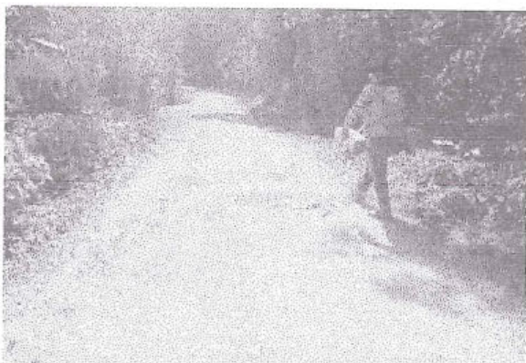
foto 18: Superficie de rodadura con afirmado, en la progresiva 2+000, con estado de transitabilidad regular.
