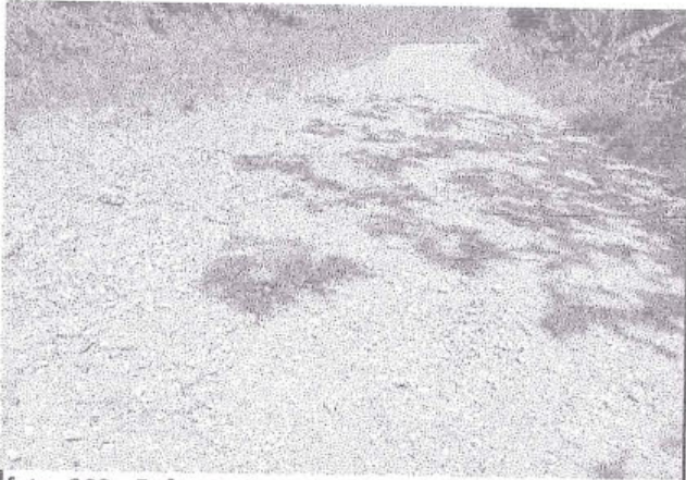
foto 209: Deformacion, de nivel de gravedad 2, en la progresiva 7+000 al 7+121
