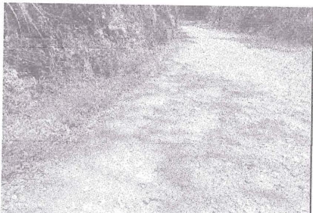
foto 208: Erosión, de nivel de gravedad 1, en la progresiva 6+940 al 6+995
