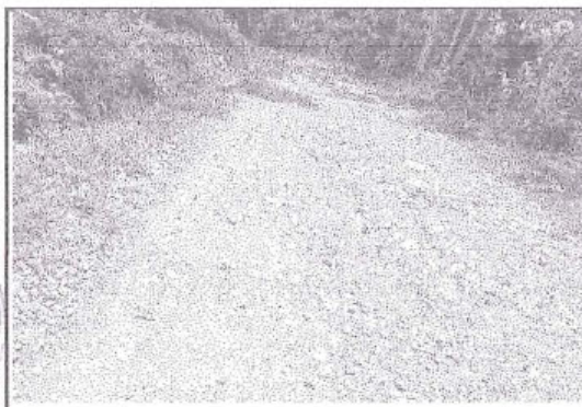
foto 262: Deformación, de nivel de gravedad 2, en la progresiva 1+000 al 1+170.
