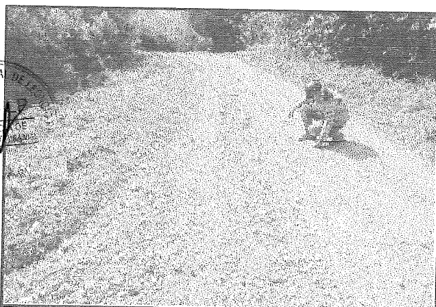
foto 265: Erosion, de nivel de gravedad 2, en la progresiva 0+500 al 0+703.
