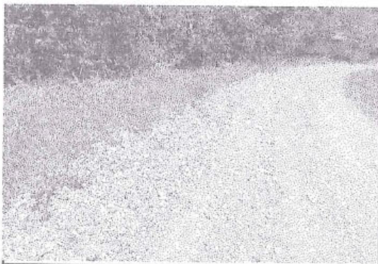
foto 252: Deformación, de nivel de gravedad 2, en la progresiva 0+050 al 0+100.
