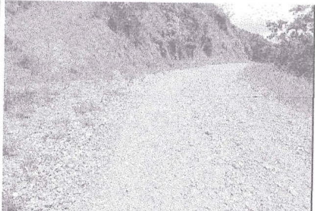
foto 210: Erosión, de nivel de gravedad 1, en la progresiva 7+140 al 7+235
