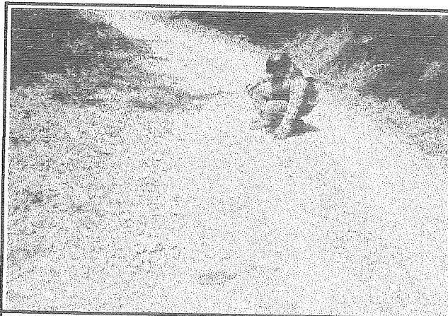
Foto 266: Deformacion, de nivel de gravedad 3, en la progresiva 0+752 al 0+877
