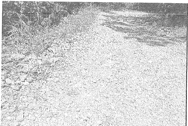
foto 176: Deformación, de nivel de gravedad 1, en la progresiva 3+500 al 3+538
