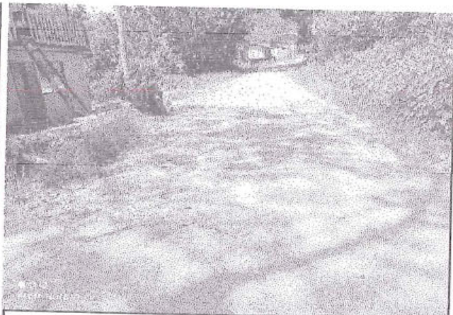
foto 164: Baches, de nivel de gravedad 2, en la progresiva 2+259 al 2+309
