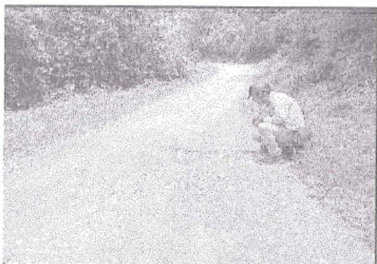
foto 258: Baches, de nivel de gravedad 1, en la progresiva 0+610 al 0+675
