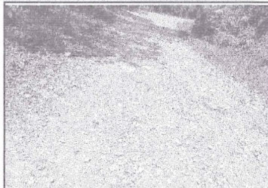
Foto 261: Erosion, de nivel de gravedad 3, en la progresiva 0+920 al 1+000 km.
