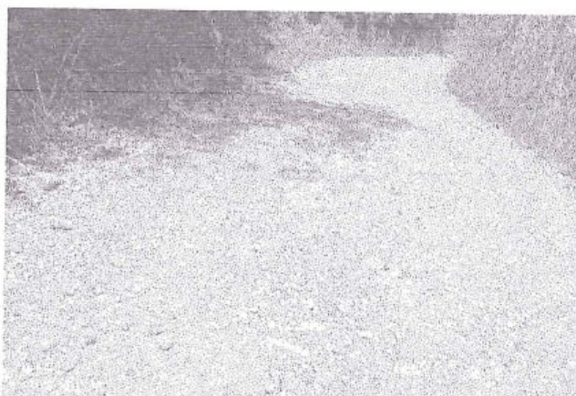
foto 202: Erosión, de nivel de gravedad 2, en la progresiva 6+370 al 6+447
