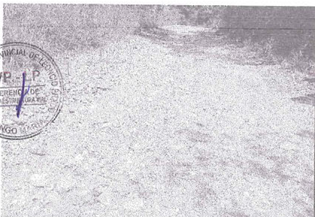
foto 223: Erosión, de nivel de gravedad 1, en la progresiva 8+460 al 8+500
