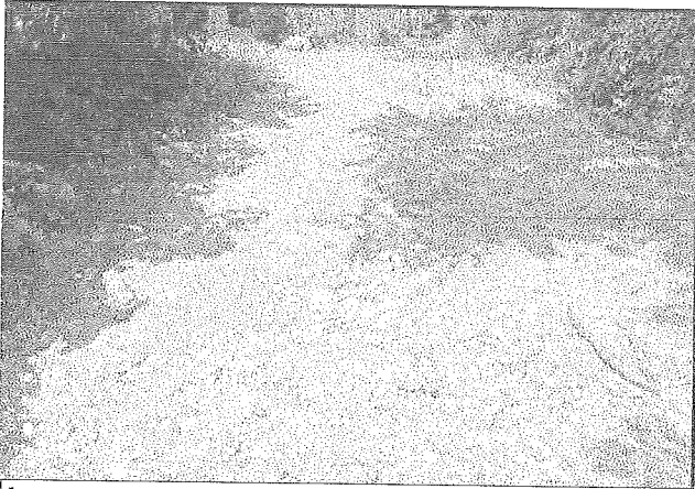
foto 173: Deformacion, de nivel de gravedad 2, en la progresiva 3+240 3+340
