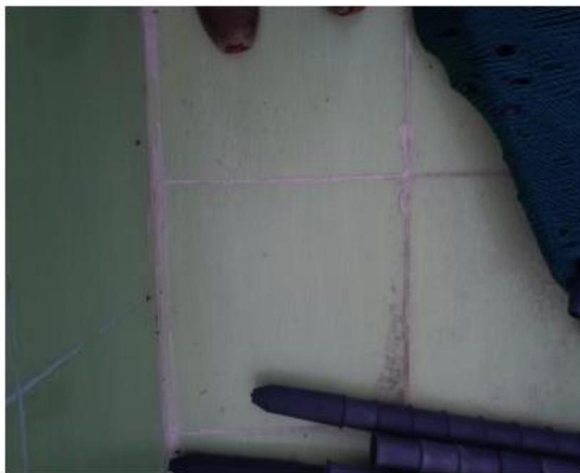
Panel fotográfico de la necesidad de sellado de juntas de loza de mayólica techo de caseta de control de turistas
