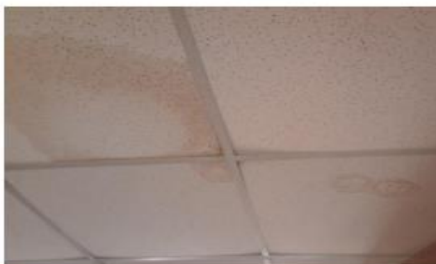
Panel fotografico de la necesidad del cambio de baldosas deterioradas por goteras
