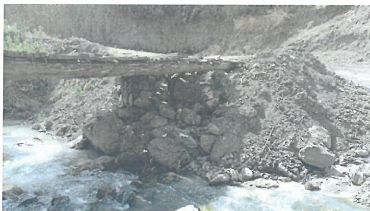
Vista 05: Vista del estribo derecho con muros de piedra colapsado y relleno de material suelto, estructuralmente inestables, ancho 4.0m.
