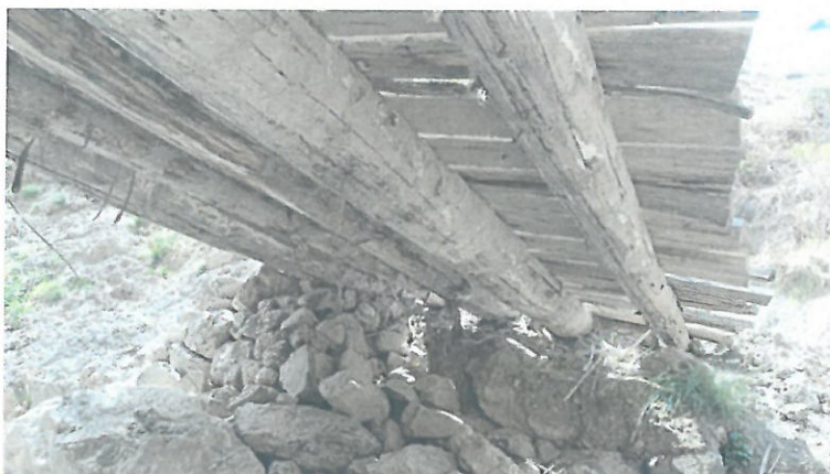
Vista 04: Vistas de la superestructura del Puente Existente, nótese los elementos de madera deteriorados, rotos e instalados sin criterios técnicos adecuados, apoyados sobre muros de piedra sin estabilidad.
