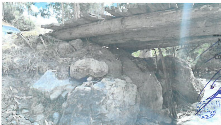
Vista 06: Vista del estribo izquierdo con muros de piedra simplemente colocados, estructuralmente inestables, cimentaciones superficiales, ancho 4.0m.
