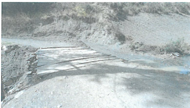
Vista 07: Vista de la plataforma del puente con elemento de madera instalados de manera inadecuada e inestable, sin elementos de sujeción adecuados, ancho 3.5m.
