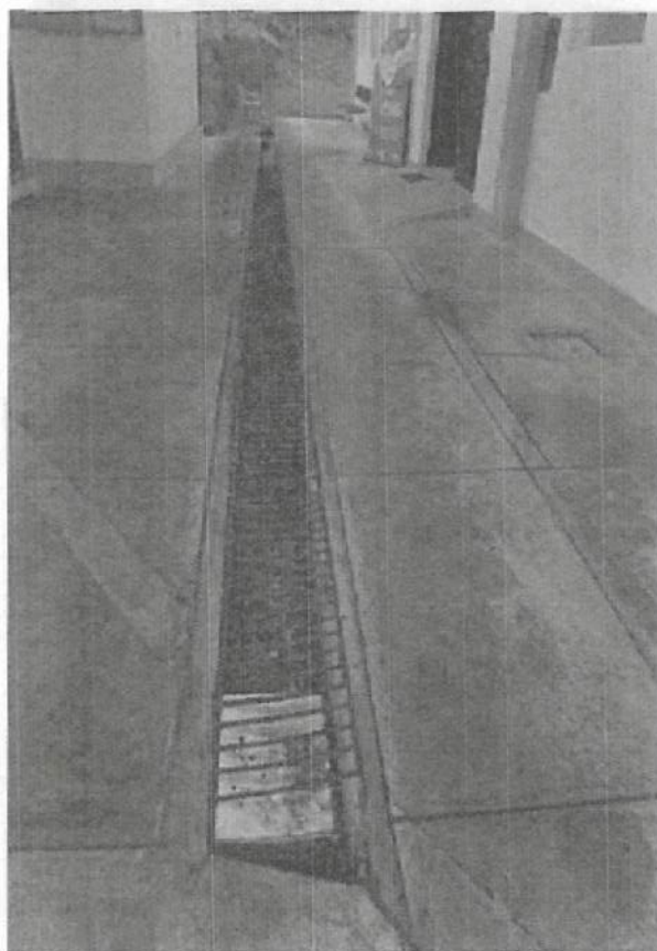
FOTO N°04. VISTA DE REJILLA DE CUNETA EN MAL ESTADO.
