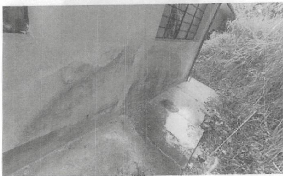
FOTO N°06. PRESENCIA DE FILTRACIÓN DE AGUA POR CANALETAS AVERIADAS
