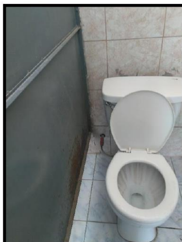
Fotografía 05 y 06: Cerámica de piso y pared parchados; separadores de inodoros y urinario oxidados
