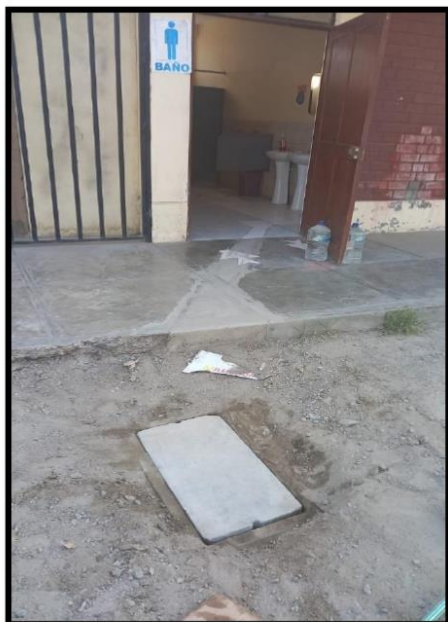
Fotografía 15: Caja de desagüe existente a rehabilitar
