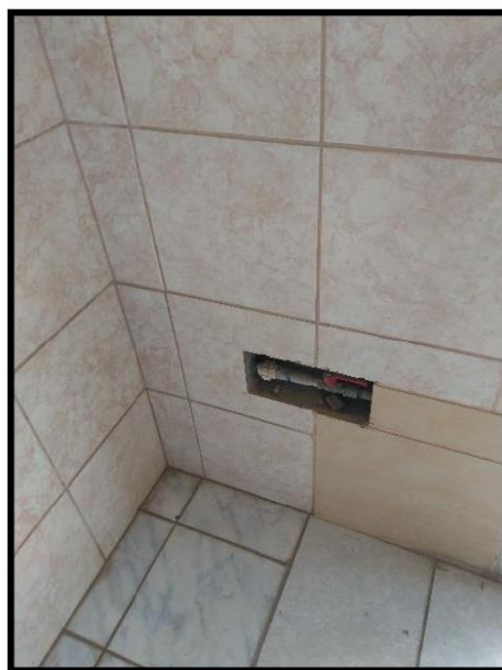
Fotografía 07: Válvula de control deteriorado
