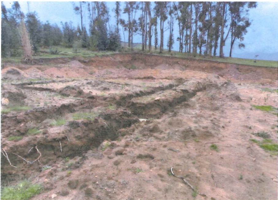
Imagen N° 05.04: Zanjas de Cimentación (Zapatas y Vigas de Cimentación) ejecutados en el Módulo 01, colmatados y con perdida de medidas y forma
