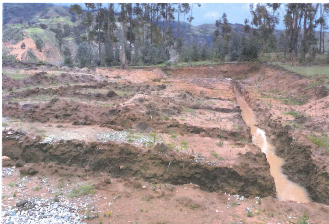
Imagen N° 05.07: Zanjas de Cimentación (Zapatatas y Vigas de Cimentación ) ejecutados en el Módulo 02
