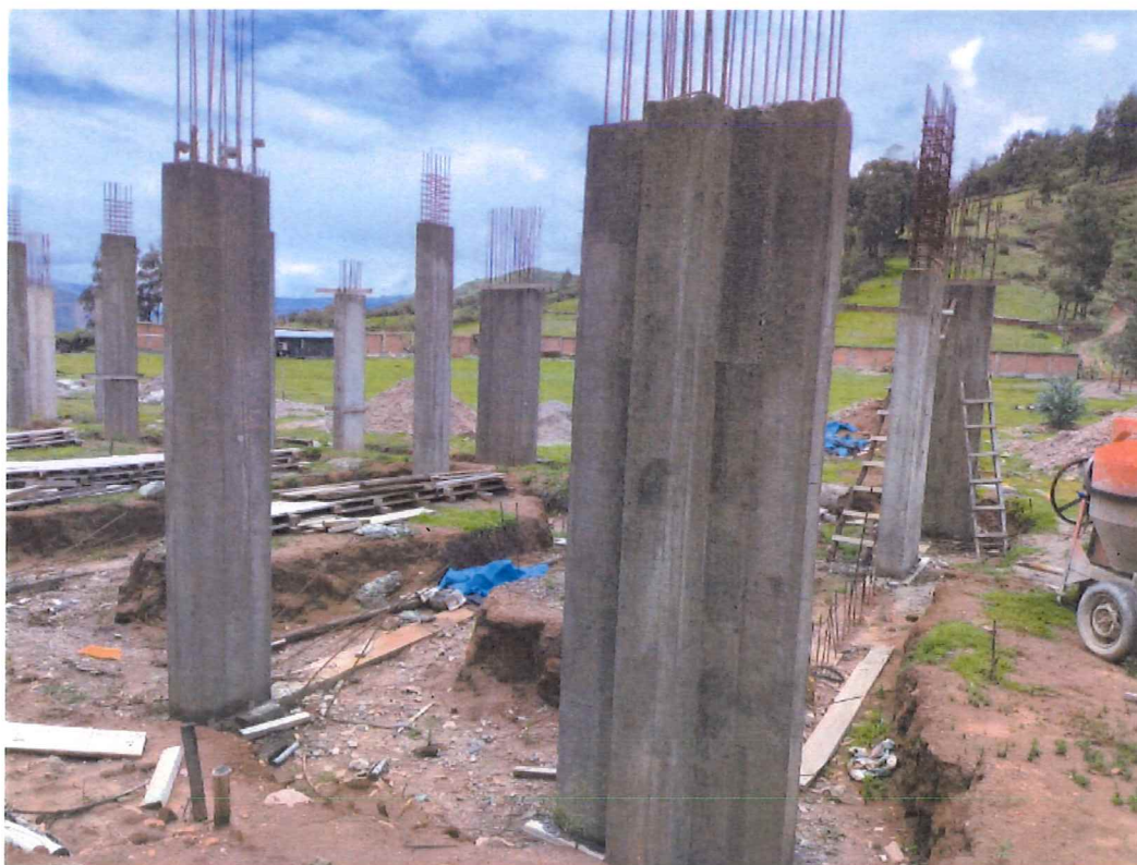
Imagen N° 05.08: Columnas y Placas de Concreto Armado ejecutados en el Módulo 03
