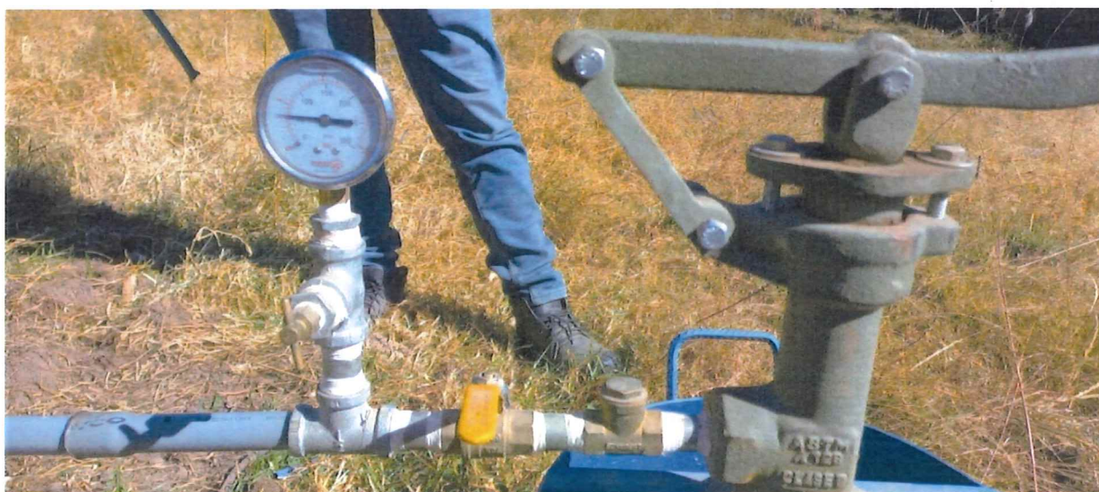
IMAGEN N° 3.01: MEDICIÓN DE PRESIÓN DE AGUA EN EL PUNTO DE SUMINISTRO ( PRESIÓN = 35 MCA Y TUBERÍA 3/4")
