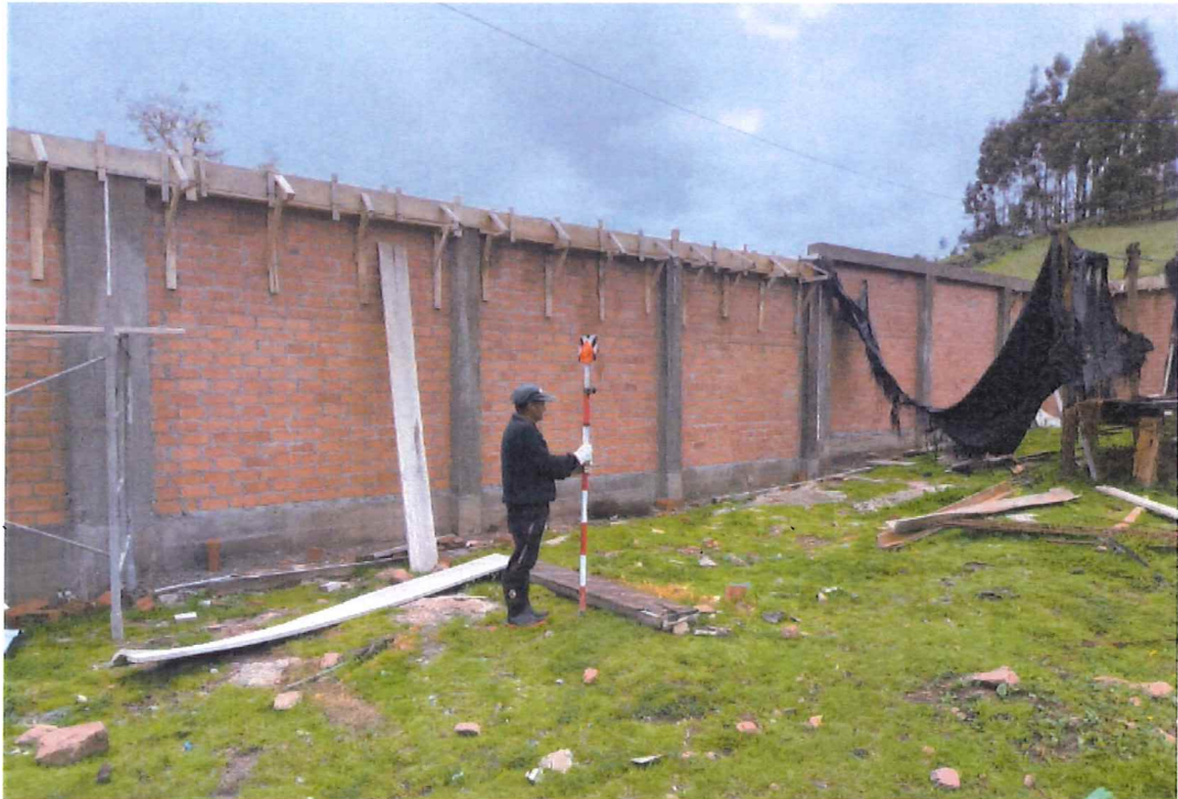
Imagen N° 05.14: Cerco Perimétrico a nivel de albañilería confinada en tramo de cerco AB
