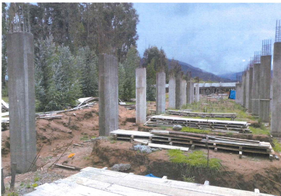
Imagen N° 05.09 Columnas y Placas de Concreto Armado ejecutados en el Módulo 03
