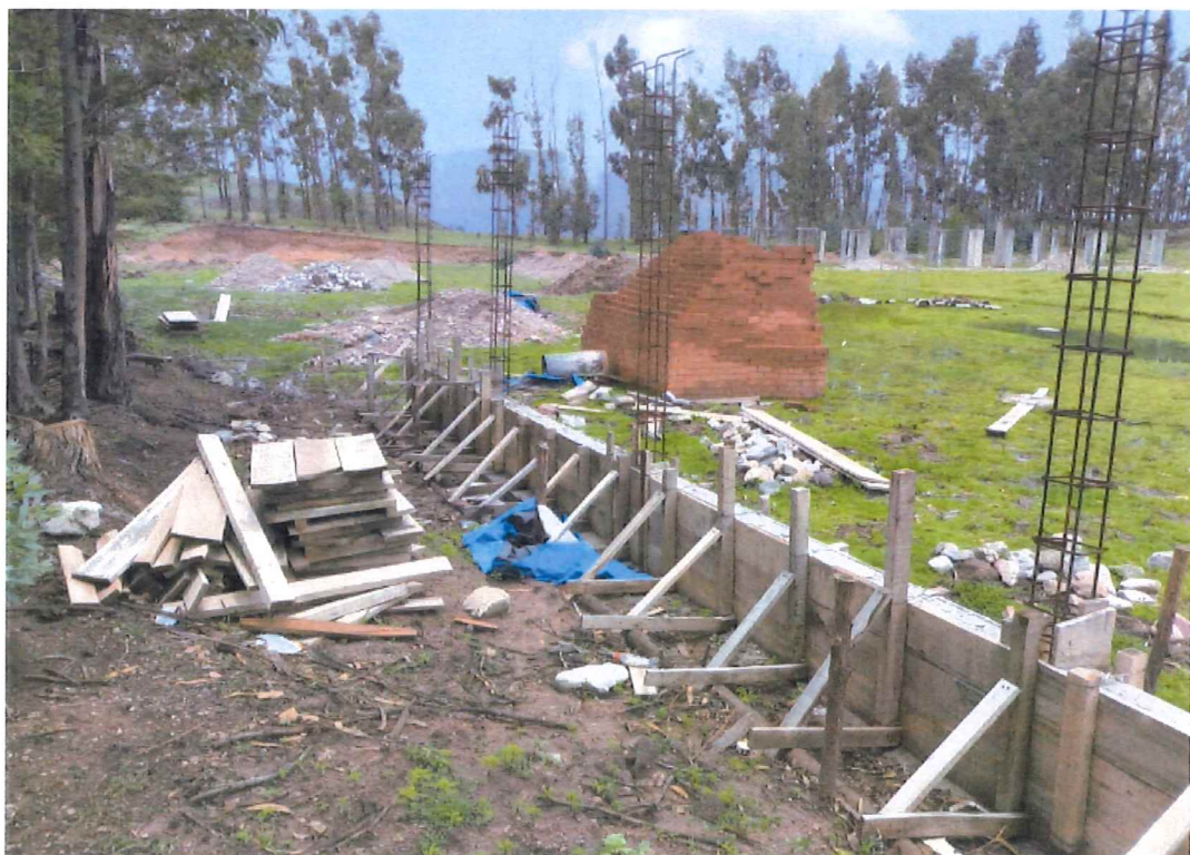
Imagen N° 05.14: Cerco Perimétrico a nivel de sobrecimiento en el tramo de DE
