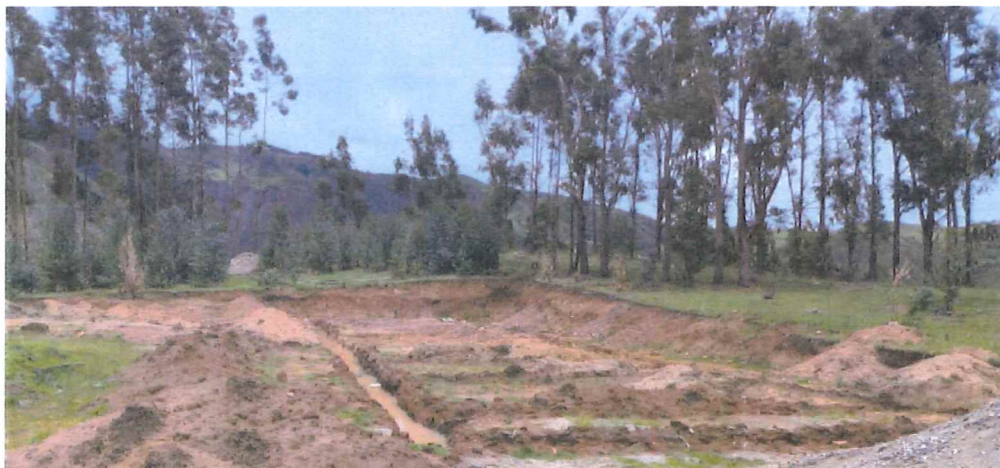
Imagen N° 05.03: Explanación de terreno por corte al talud de terreno natural
