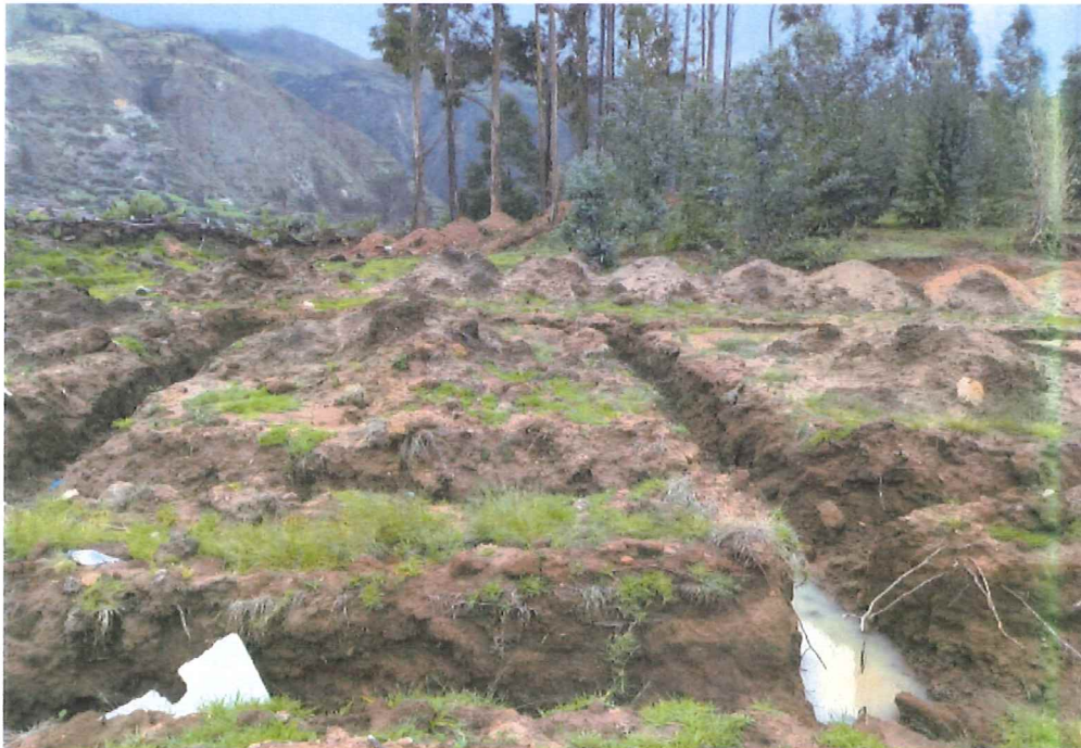
Imagen N° 05.10: Zanjas de Cimentación (Zapatas y Vigas de Cimentación ) ejecutados en el Módulo 04
