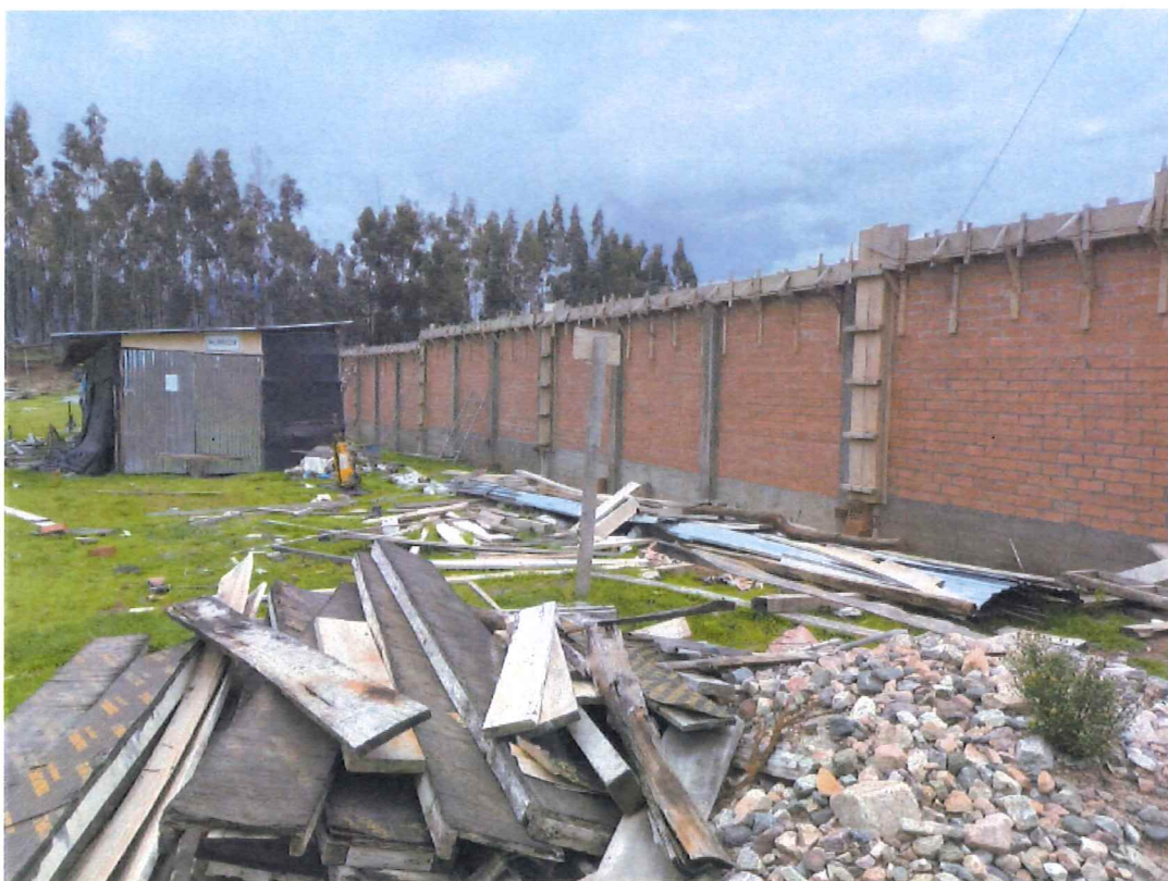
Imagen N° 05.13: Cerco Perimétrico a nivel de albañilería confinada en tramo de cerco AB
