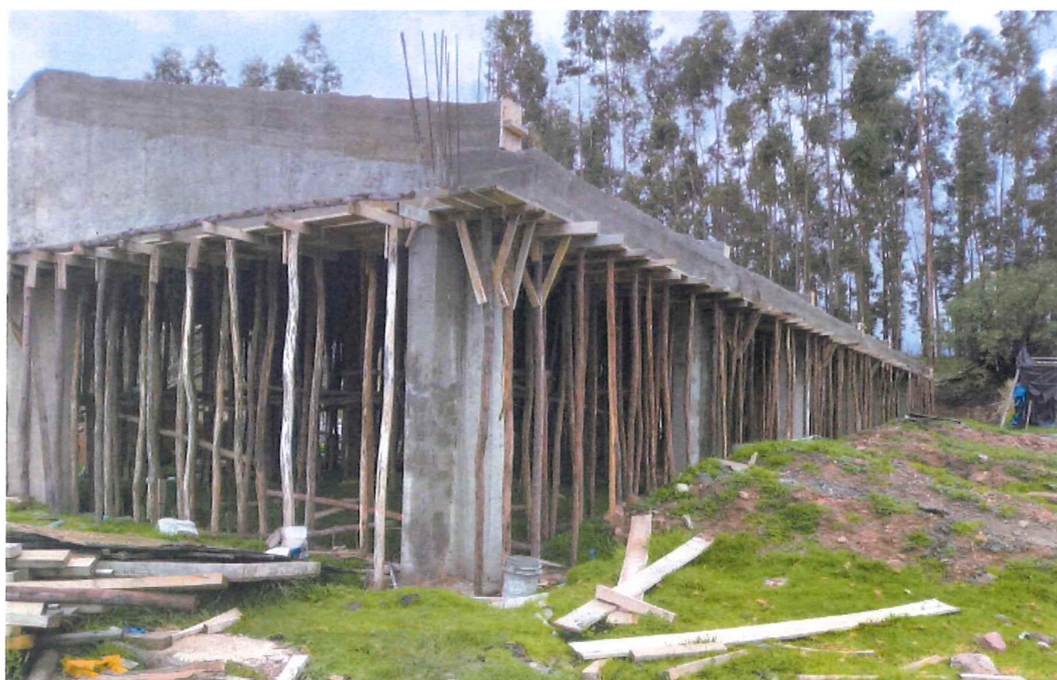
Imagen N° 05.12: Ejecución del Módulo 05, con techado aligerado.
