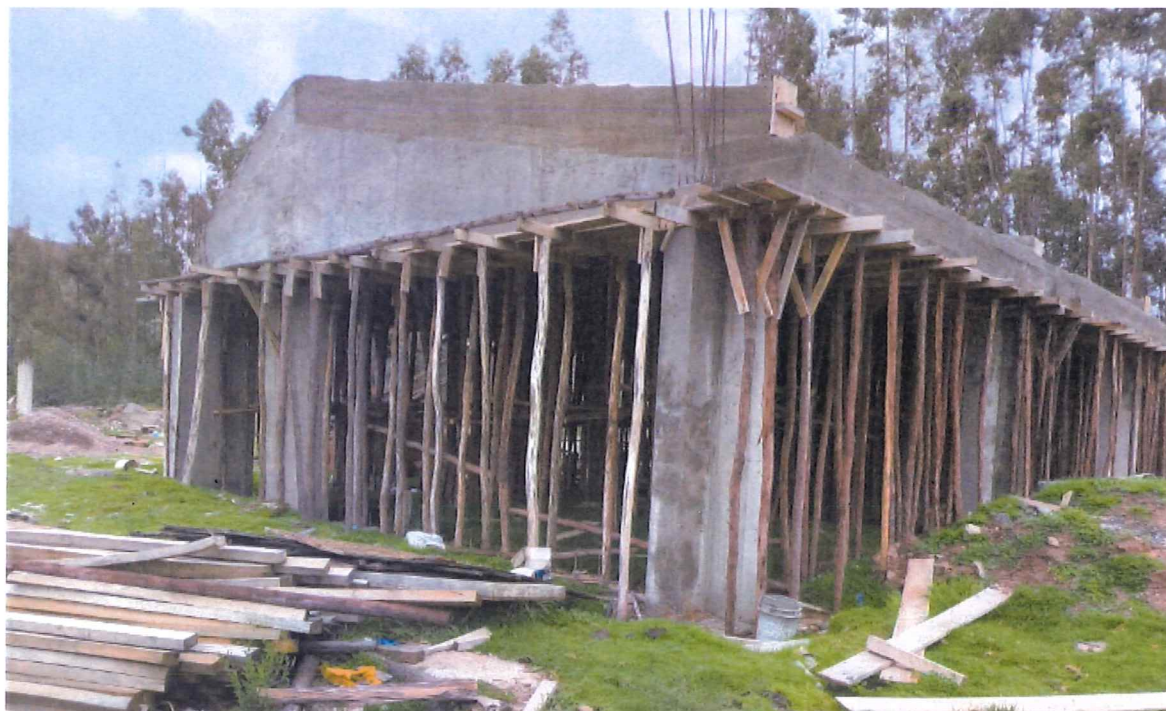
Imagen N° 05.11: Ejecución del Módulo 05, con techado aligerado.
