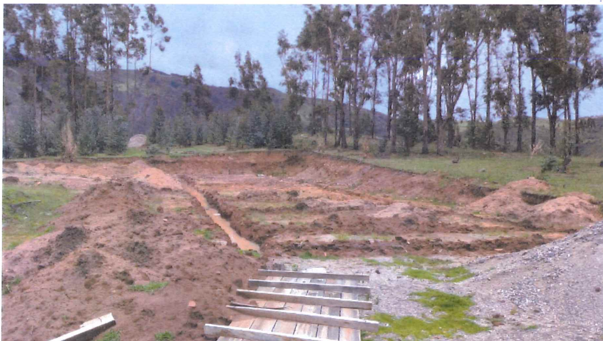
Imagen N° 05.06: Zanjas de Cimentación (Zapatatas y Vigas de Cimentación ) ejecutados en el Módulo 02
