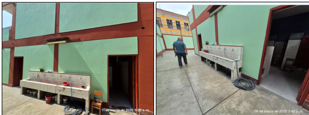
Imagen N°03: Vista exterior de los SSHH de Prima y Secundaria a intervenir con el enchape de lavadero corrido, cambio de griferías y cambio de luminarias. Tampoco cuenta con tanque elevado para dar mantenimiento a las baterías de baño.
