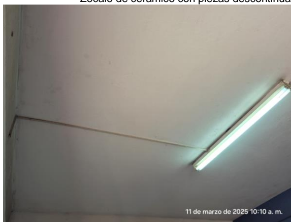
Imagen N°05: SSHH Hombres: Luminarias con alimentación con energia a traves de canaletas, cajuelas de llave de paso valvulas compuerta con desgaste.
