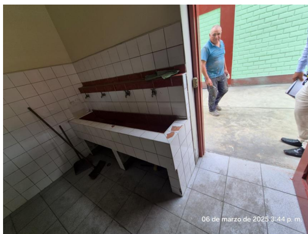
Imagen N°06: SSHH Mujeres: Lavadero corrido con griferia con desgaste, inodoros sin tapa. Zocalo con piezas de ceramico discontinuados en el mercado. Puertas de los cubiculos con desgaste para realizar mantenimiento.
