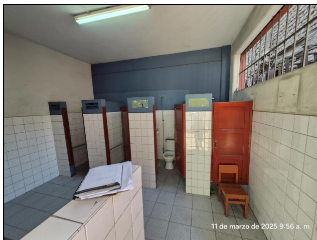
Imagen N°04: SSHH – Hombres, se aprecian las puertas de cubiculos en mal estado, y la pintura de paredes con desgaste, inodoros sin tapa, cambio de luminarias, instalacion sumideros corridos en piso. Zocalo de ceramico con piezas discontinuadas en el mercado. De la misma forma del piso.
