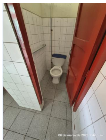
Imagen N°06: SSHH Mujeres: Lavadero corrido con griferia con desgaste, inodoros sin tapa. Zocalo con piezas de ceramico discontinuados en el mercado. Puertas de los cubiculos con desgaste para realizar mantenimiento.
