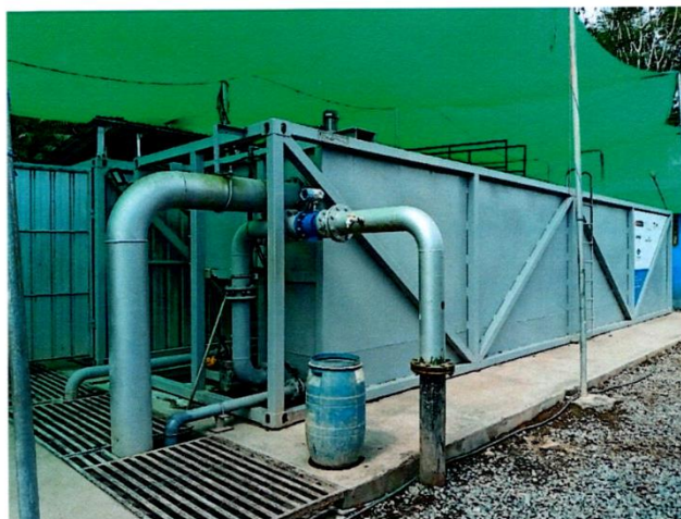
Imagen N° 05: Planta portátil de tratamiento de agua potable.
