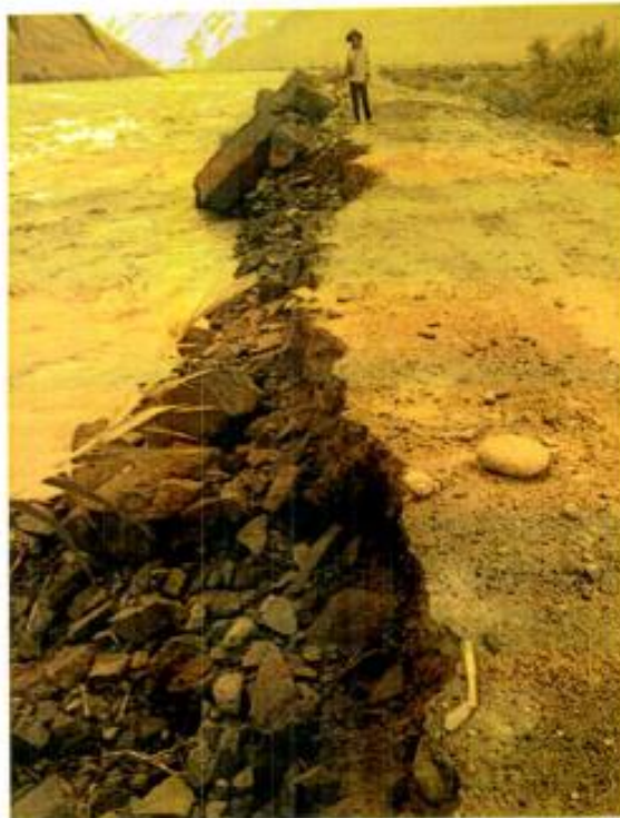
vista de defensa ribereñas afectadas por el incremento del caudal del río Ocoña.
