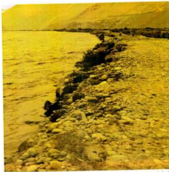
vista de defensa ribereñas afectadas por el incremento del caudal del río Ocoña
