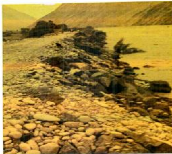
vista de defensa ribereñas afectadas por el incremento del caudal del rio Ocoña
