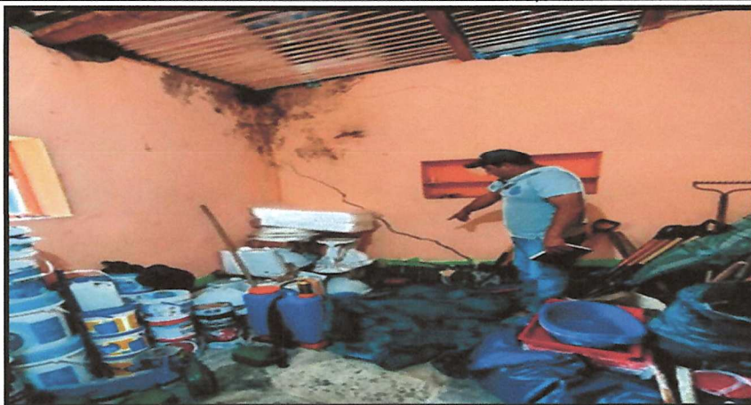
Foto: 02 Presencia de Rajaduras, en pared de adobe.
