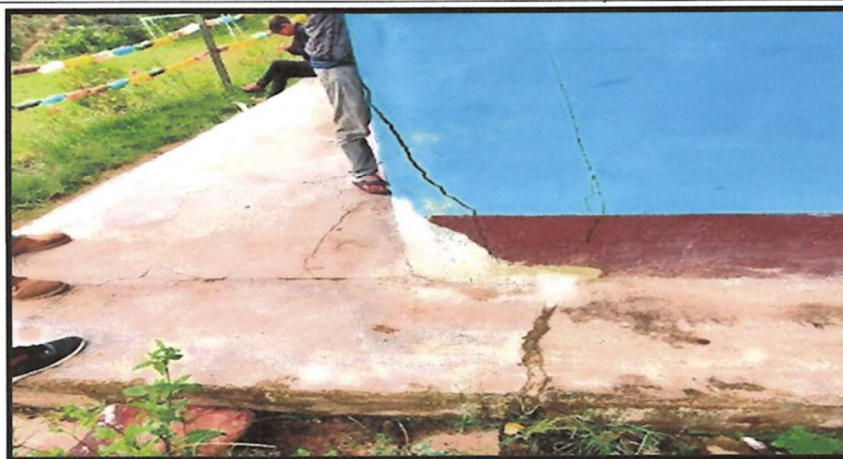
Foto: 02 Vista de pared exterior fallada.
