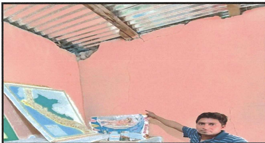
Foto: 03 Vista de Desprendimientos de parte de pared en aula.
