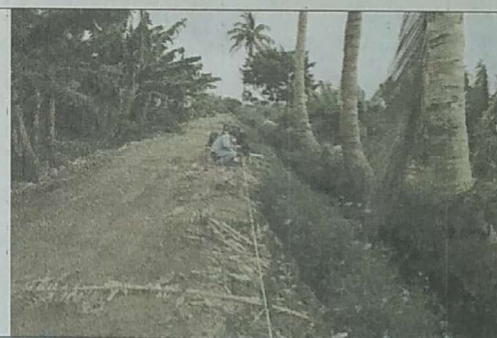
FOTO N° 04: Esta vista muestra el trabajo de medición y estacado cada 20 m., apoyado con wincha metálica, cordel y comba. Las plantas a lo largo del canal saldrán cuando se construya el canal, es una decisión y acuerdo asumido por los mismos beneficiarios, su directiva y la municipalidad distrital Miguel Checa.
