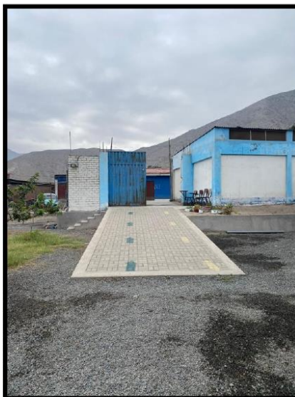
Fotografía N°02.- Desde esta ubicación se puede observar la futura modificación de la rampa, al no cumplir con la pendiente requerida para una rampa que facilite el acceso a personas con discapacidad.
