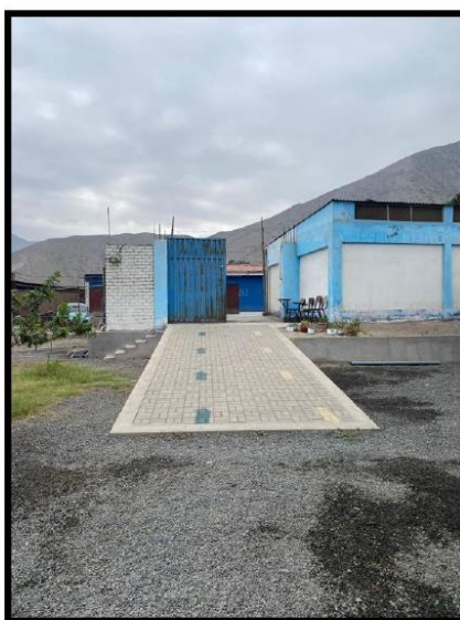
Fotografía N°06.- Desde esta ubicación se puede observar la futura modificación de la rampa, al no cumplir con la pendiente requerida para una rampa que facilite el acceso a personas con discapacidad.
