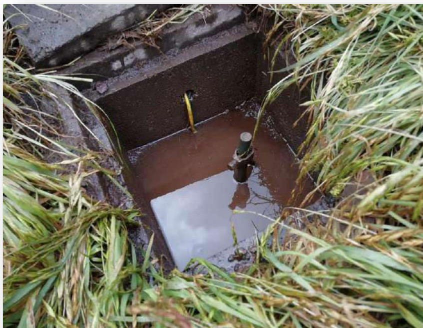
IMAGEN N° 38: Estado actual del pozo a tierra
