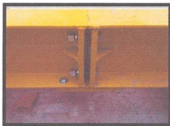
Empalme o union de vigas principales
