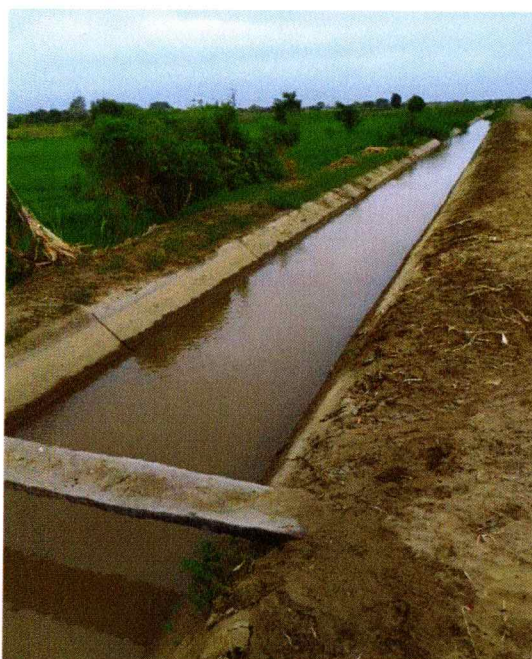
Fotog. Tramo revestido Canal San Luis, km 0+000 – km 1+315
