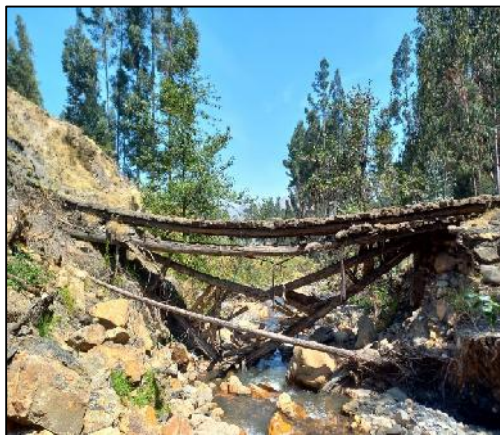
estructura (viga de madera deflectado).
