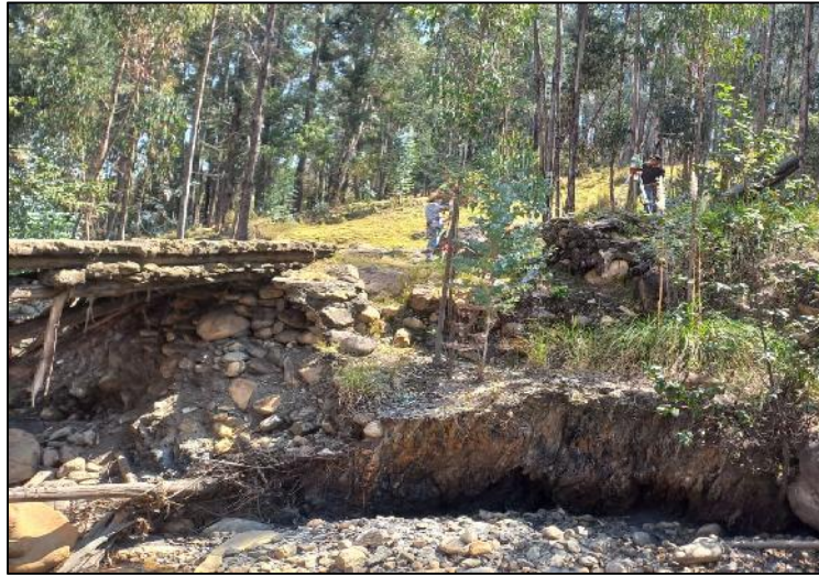
Foto3: Socavación de Subestructura.
