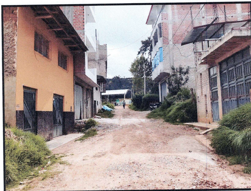
FOTO N°03 Vista fotográfica del Vista del Jr. La Esperanza, donde se aprecia que la vía se encuentra en terreno natural con material de afirmado en inadecuadas condiciones y no cuenta con veredas.
